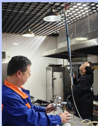
工作人员正在进行报警器检测
