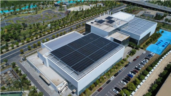
梧桐雨体育中心分布式屋顶光伏
